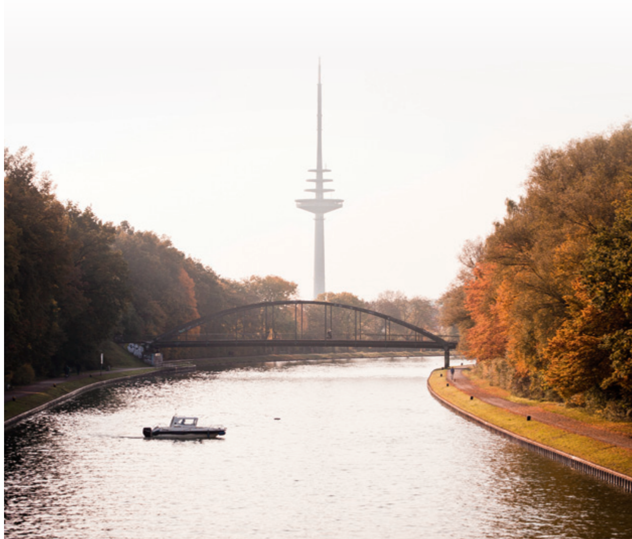
Durch den Ausbau der Stadtstrecke Münster können künftig größere Mengen über größere Schiffe bis in den Mittellandkanal transportiert werden.
