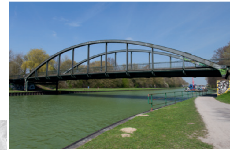
Pleistermühlenweg-Brücke: Die Anliegerbrücke wird voraussichtlich ab Mitte 2017 neu errichtet und an den künftigen DEK-Querschnitt angepasst.
