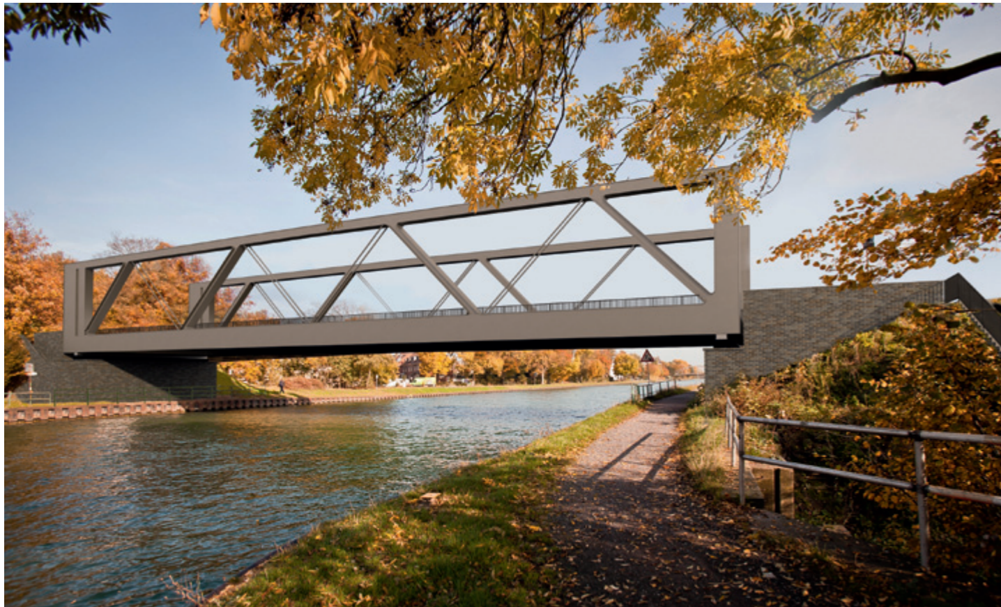
Das Design der neuen Schillerstraßen-Brücke ist an das Erscheinungsbild der alten Überführung angelehnt.
